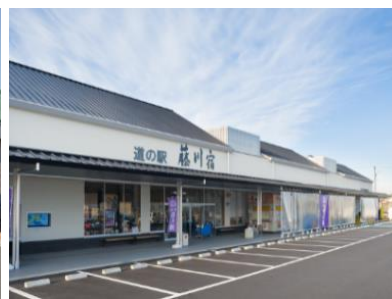
道の駅藤川宿 (藤川町)
