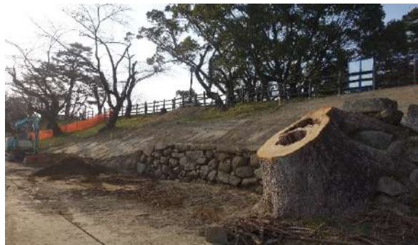
菅生川端石垣整備
