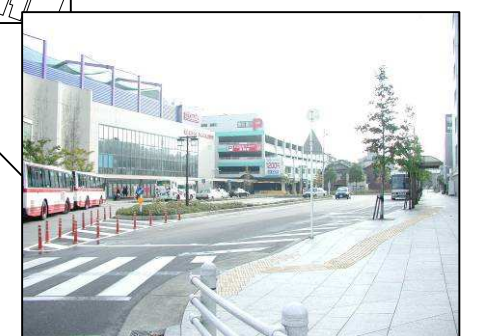
整備済みの南口広場
