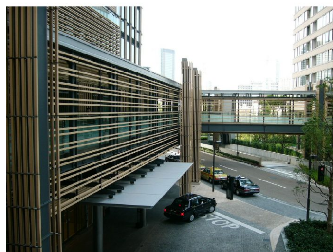
▲ホテル棟へ向かうペデストリアンデッキ（外観）
