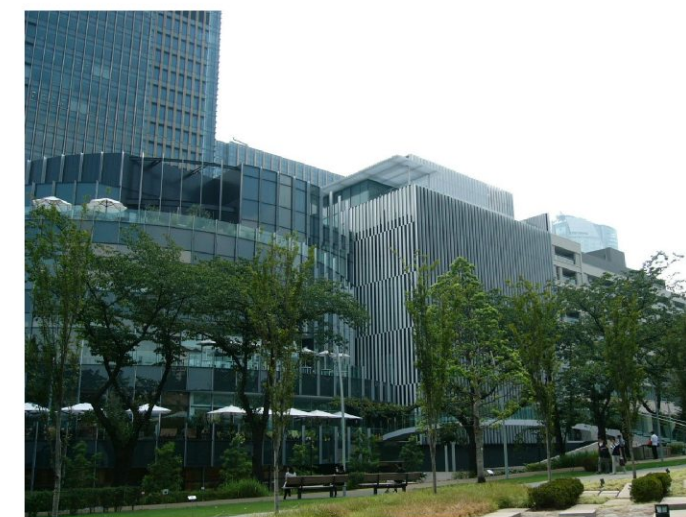
▲ガーデンテラスの縦格子を活かした外観
