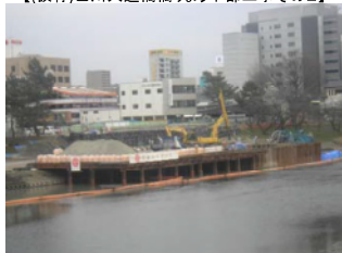
乙川河川緑地整備状況 【（仮称）乙川人道橋橋りょう下部工事その2】
