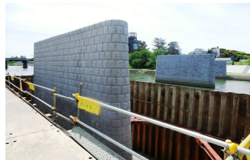
乙川人道橋橋りょう下部工事その2 [4月23日撮影]
