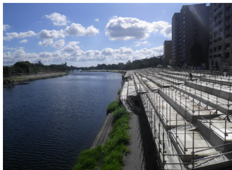
乙川河川緑地：栈敷の設置状況
