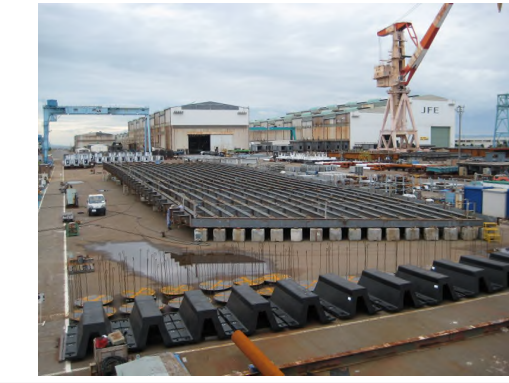
(仮称)乙川人道橋・工場での仮組立状況(A1橋台～P2橋脚)
