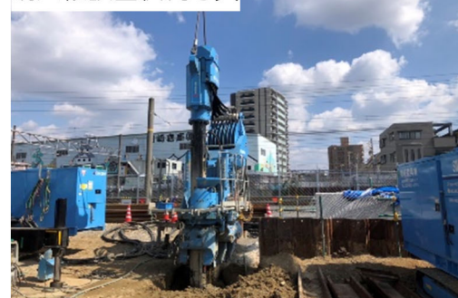
鋼矢板設置状況写真
