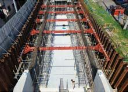
□現場打ち擁壁
