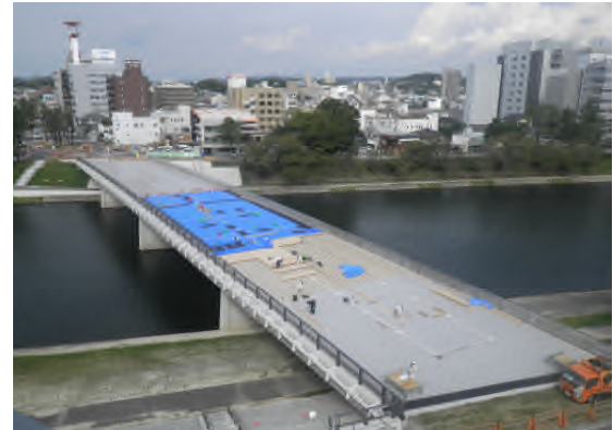
桜城橋の木装化状況
