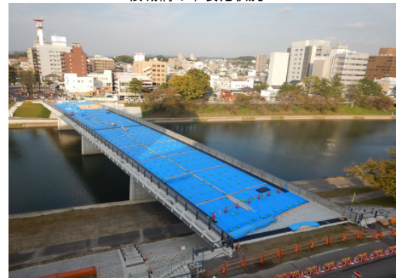
桜城橋の木装化状況
