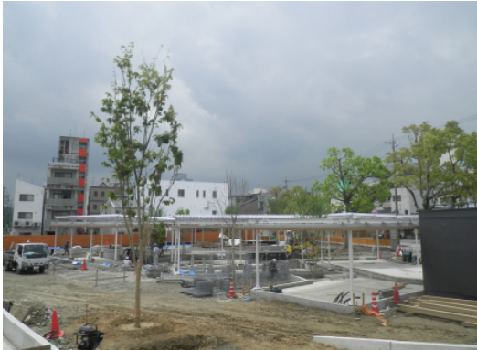
籠田公園の工事状況
