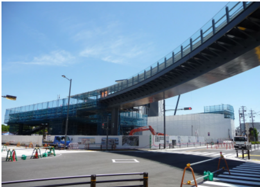
ベデストリアンデッキ整備工事の状況
