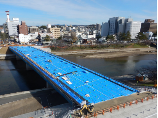
桜城橋の木装化状況
