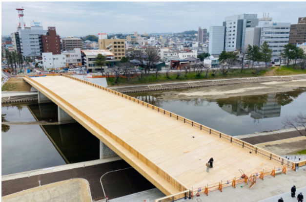
桜城橋工事の状況
