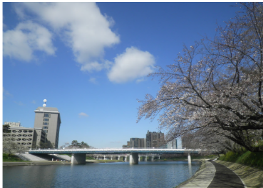
乙川の桜と工事中の桜城橋(サクラノシロバシ)
