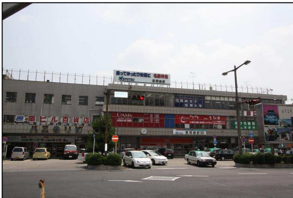
駅舎と一体的な整備が望まれている築50年が経過した駅ビル（岡ビル）
