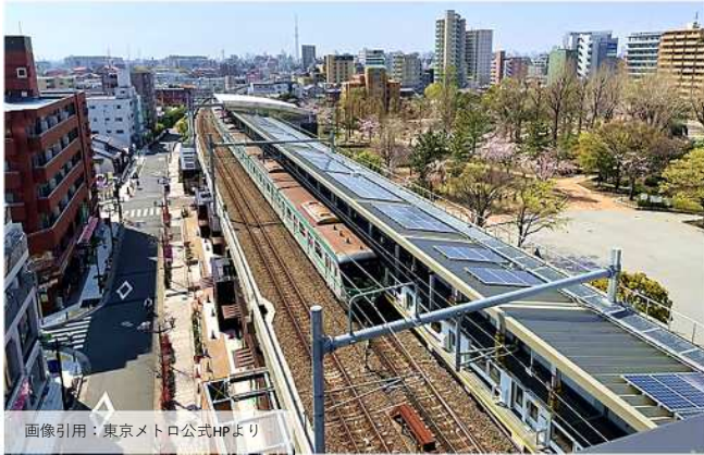
駅に太陽光発電システムを設置 (例：北綾瀬駅)
