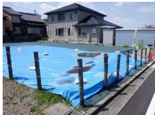
④ 前面道路から
