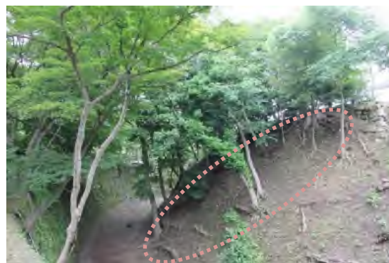
写真 2 -57 堀底から続く土塁の樹木 (本丸土塁・清海堀)
