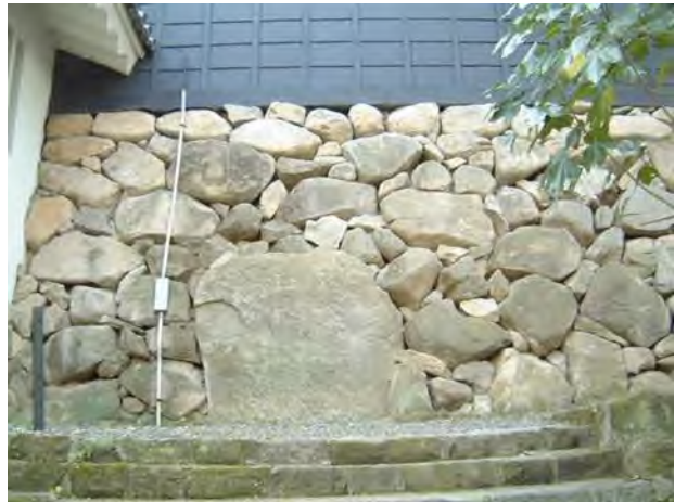
写真 2-33 天守台石垣の野面積みと鏡石
