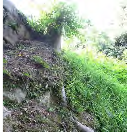
写真 2-26 石垣天端の樹木
