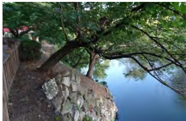
写真 2-30 石垣天端の樹木
