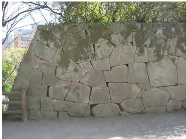
写真 2-34 本丸御門石垣の切込接ぎ
