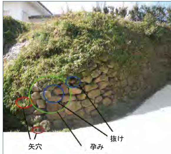
写真 2-32 No.251 石垣の抜けと孕み出し
