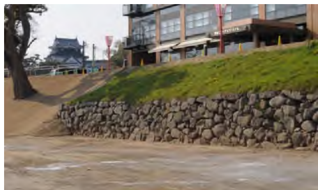
写真 2-35 菅生川端石垣
