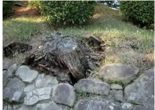
写真 2-17 伐採木根付近の空部とモルタル充填
