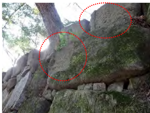
写真 2-37 埋門の桁の欠き込み加工痕
