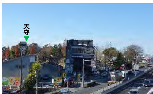
03 康生通南歩道橋より望む
