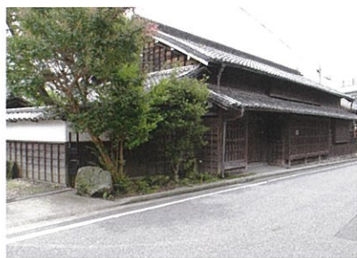
主屋(北東側から)
