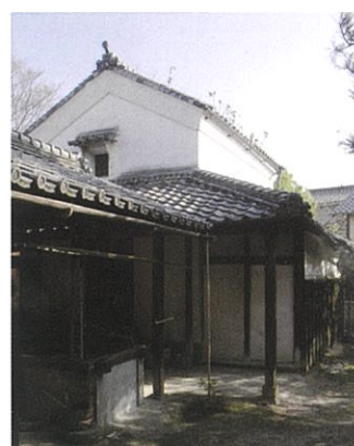
土蔵(手前は井戸屋)
