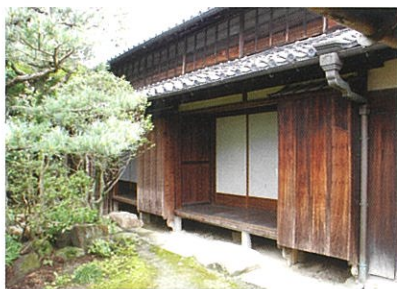
主屋(南東側から)
