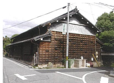
主屋(西側から)
