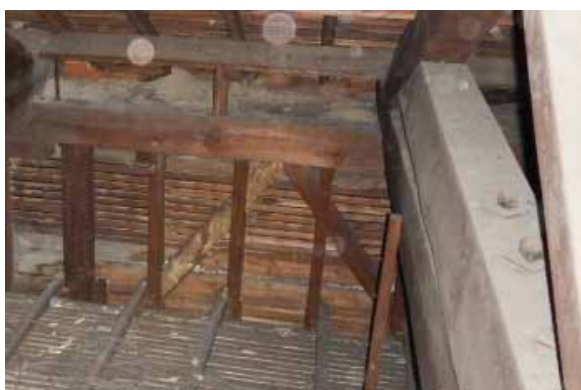
図 1-29 公会堂 筋交い（小屋裏より）
