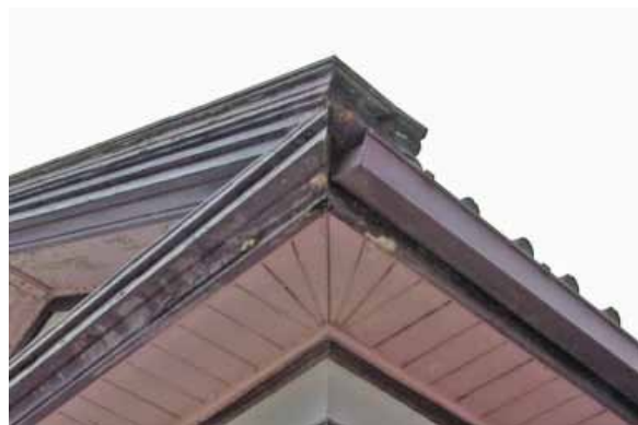
図1-15 公会堂 軒天井（便所棟）
