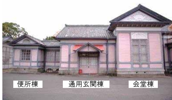
図1-11 公会堂 外観（北面）
