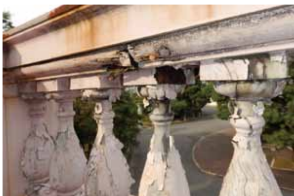
図 2-3 木製バラストレードの腐朽
