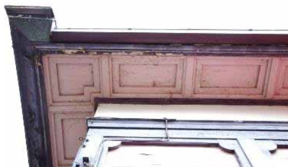
図1-14 公会堂 軒天井（通用玄関棟）
