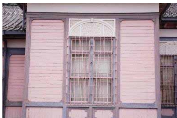
図1-12 公会堂 外壁（会堂棟・北面）
