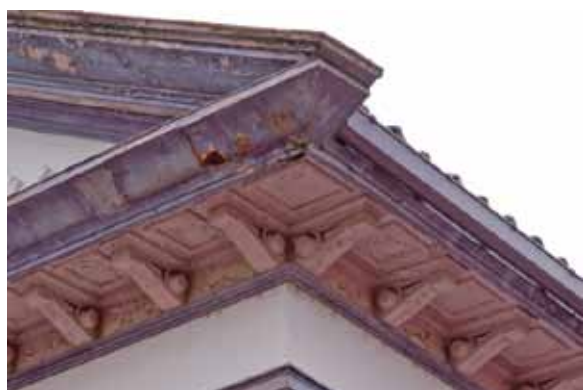
図1-13 公会堂 軒天井（会堂棟）
