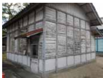
図 3-3 外壁塗装の劣化
