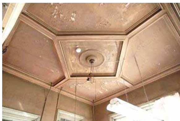
図 1-28 公会堂 控室3（天井）
