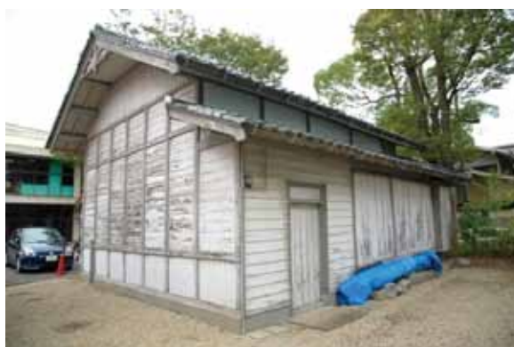
図 1-46 看守人室 外観（南面）
