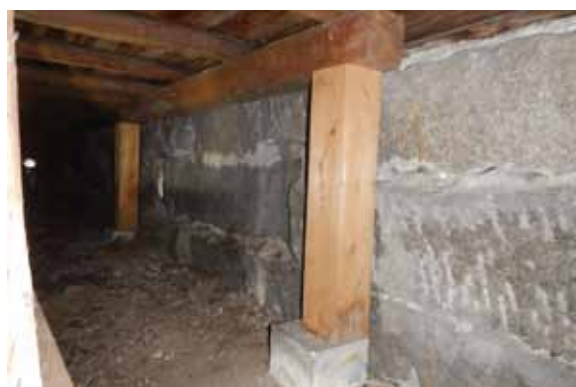
図 2-6 沈下箇所の補強（中央玄関右側）
