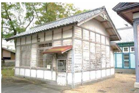
図 1-45 看守人室 外観（北面）
