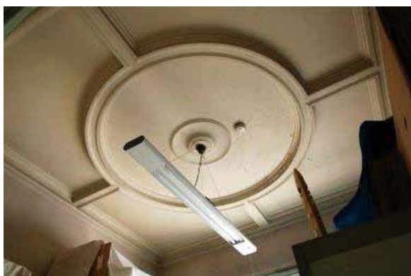
図 1-27 公会堂 控室2（天井）
