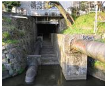
図 6 - 52 官営愛知紡績所余水路遺構
