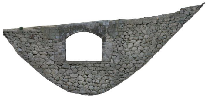
図3 R3測量：廊下橋東面石垣写真オルソ (写真オルソ：写真の歪みやズレを補正した画像)
