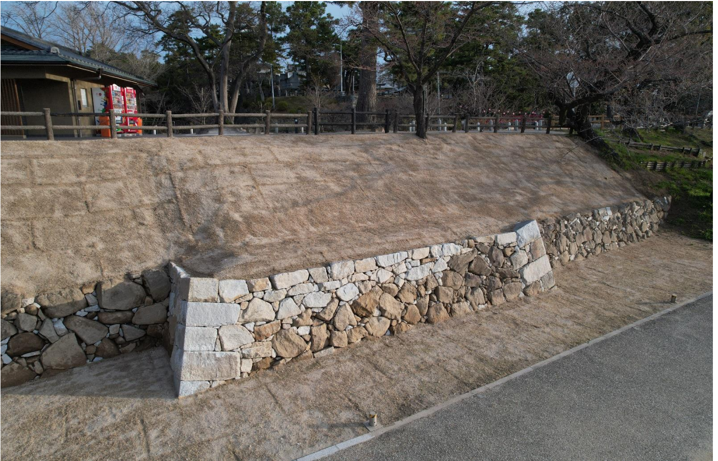
写真1 石垣整備工事が完了した菅生川端石垣西枡形（南西から）
