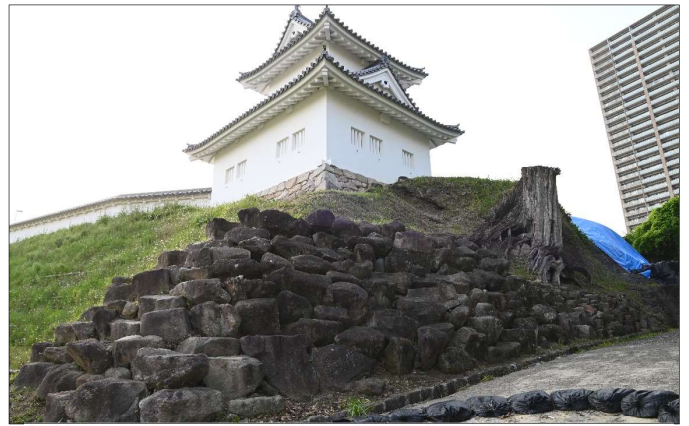
写真4 南端部の近代石積み(南東から撮影)
