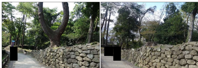
写真 14 帯曲輪南面石垣上の樹木伐採前（左）・後（右）
