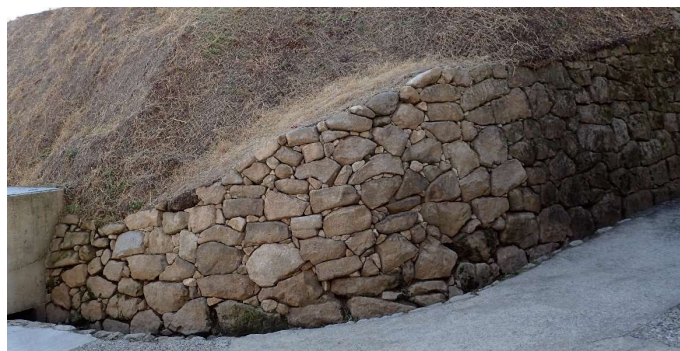
写真13 石垣修復完了
