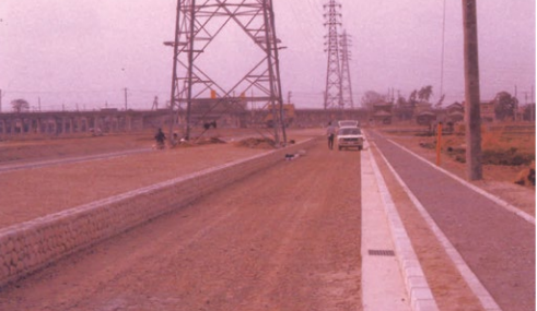
4 南部区画整理中の六名緑道付近。熊野公園隅に区画整理の記念碑がある
