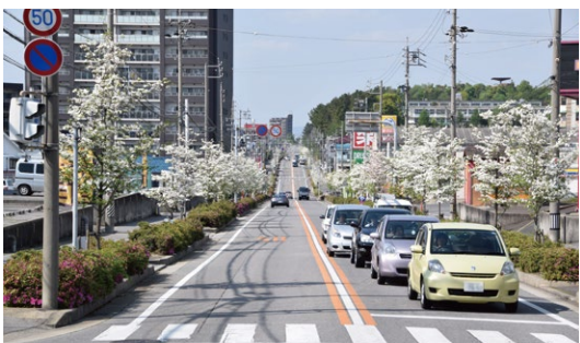
J ポプラ通り 土地区画整理事業が完了した当時は、ポプラが両側に植えられていたが、成長すると台風で倒れるようになり、学区住民のアンケート結果を基に、ハナミズキが植えられている。現在でも「ポプラ通り」とよんでいる
