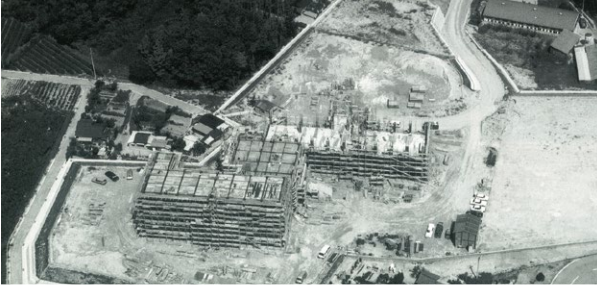
2 建設中の小豆坂小学校（昭和58年）
