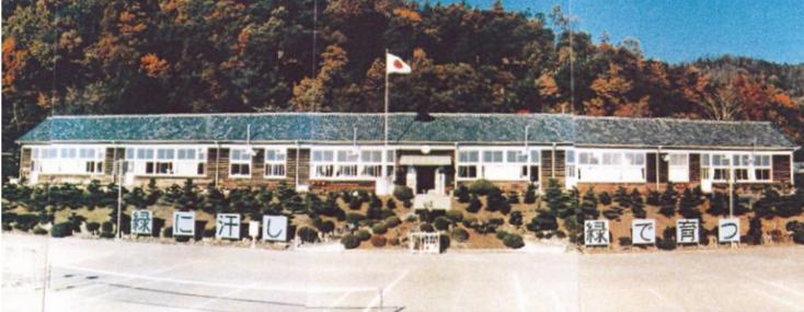
2 火災で焼失後に建てられた河合中学校
