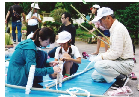
足場はしっかり固定するんだよ
