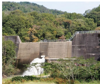
P 日影ダム 砂防ダムだが、地図にも載る大きなダム。放水景色が美しい
