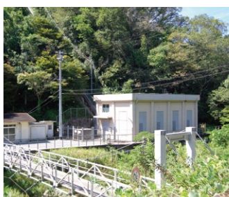
M 岩津発電所 明治30年に建設された水力発電所。中部電力管内で最古かつ最小の発電所
