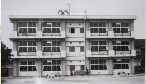
3 昭和45年に完成した細川小学校の3階建て校舎
