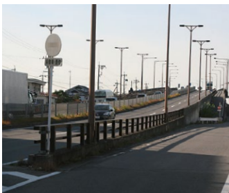
I 岡崎大橋 矢作川にかかる県道26号の橋。物流倉庫の多い大門には欠かせない産業の大動脈である
