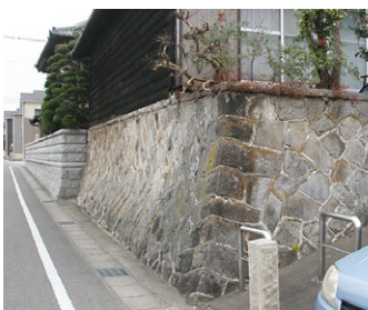
J 命塚 明治の半ばに水害時の避難場所としてつくられた。約2mもある立派な石垣で、当時の地域住民の防災意識の高さがうかがえる
