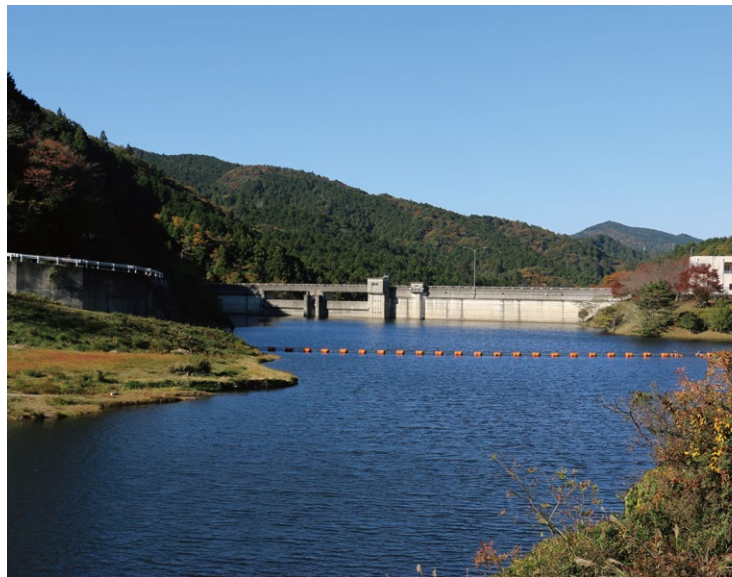
D 雨山ダム 市内東部に給水する、高さ21.5m、幅160m、集水面積2.6km 2 の生活ダム
