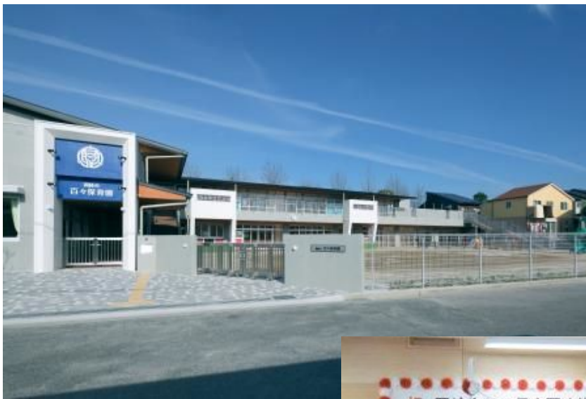
改築した百々保育園と 完工式の様子
