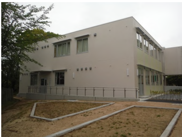
小学校増築校舎
