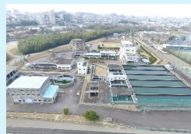
旧男川浄水場
