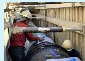
基幹管路布設工事
