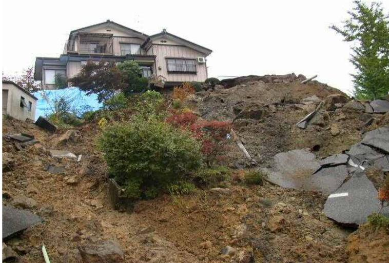
図参 1.1-⑧ 新潟県長岡市高町の盛土造成地の滑動崩落現象その2
