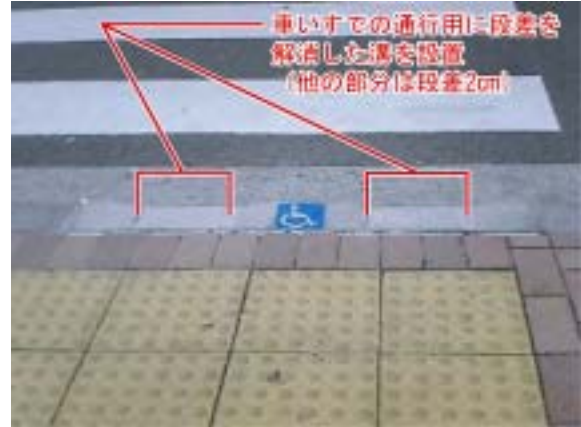
段差の解消した溝を設置
