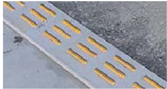
段差を解消した歩車道境界ブロック
