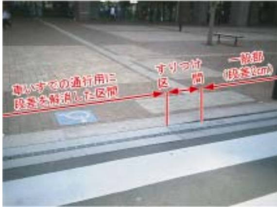
段差を解消した区間を設置
