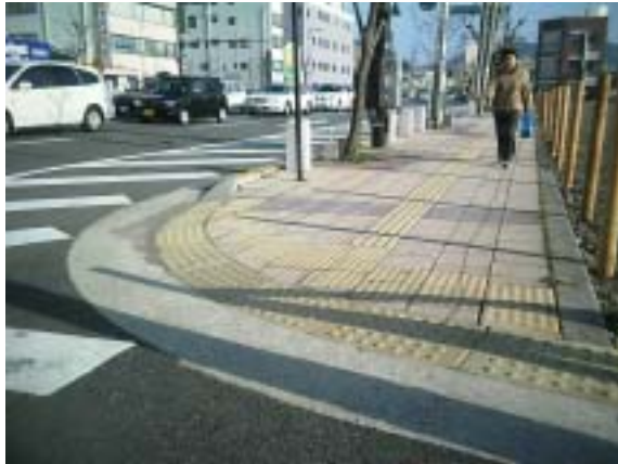
歩車道境界に視覚障害者注意喚起用ブロックを設置
