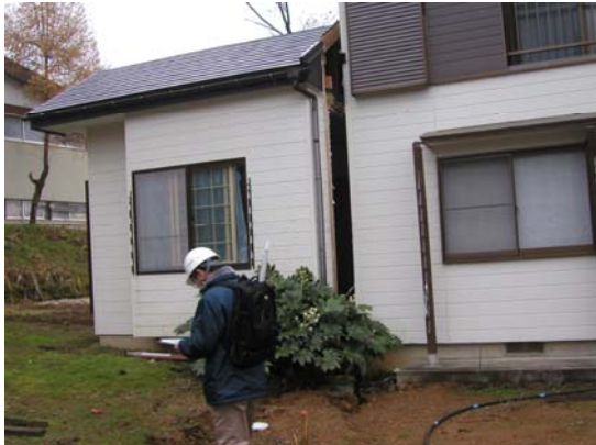
地割れにより住宅に被害を及ぼした宅地
