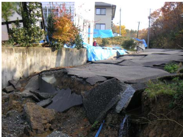
道路と同時に宅地地盤の一部が崩壊した事例
