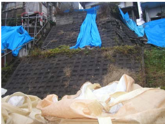
2段擁壁の上にさらにコンクリートブロックを増積みした擁壁
