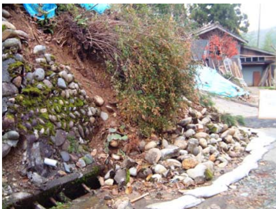
裏込めコンクリートがない空積み擁壁
