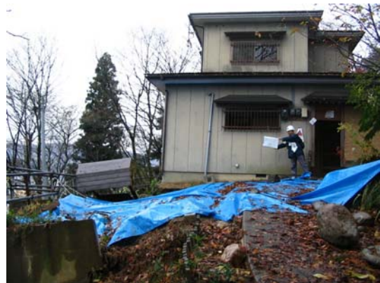
盛土が崩壊して、住宅が一部浮いた宅地
