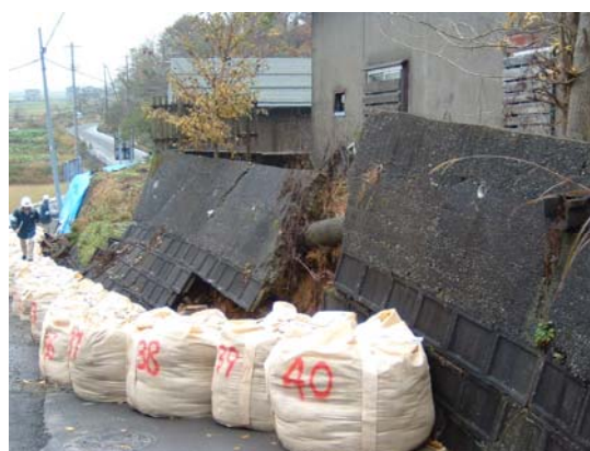
元の擁壁の上にコンクリート壁を設置し、盛土をした増積み擁壁
