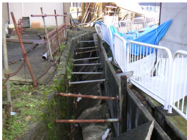
水路の崩壊に伴って宅地が被災した事例
