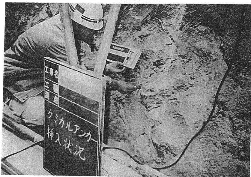
ケミカルアンカーの施工
