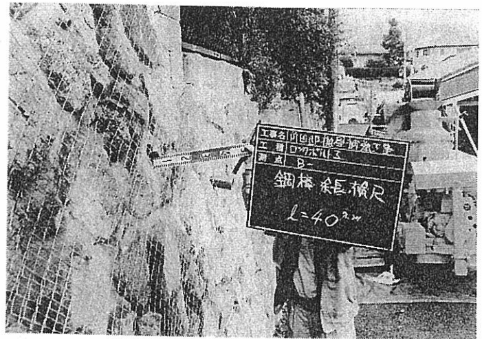
ロックボルトと金網施工中
