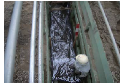
工事状況写真（防水シート設置） (提供 柏崎市)
