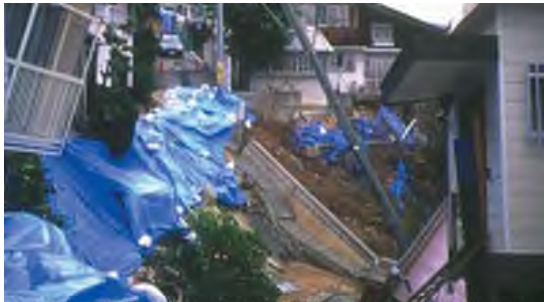
滑動崩落（兵庫県南部地震 最大震度：7）
