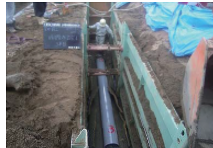
工事状況写真（暗渠排水パイプ設置） (提供 柏崎市)
