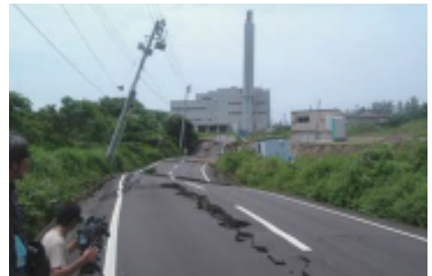
団地周辺部の被災状況（提供 柏崎市）
