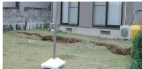
亀裂（新潟県中越地震 最大震度：7）
