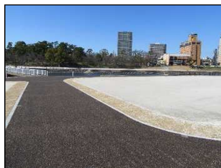
河川敷遊歩道
