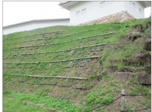
保護のための処置が施された法面
