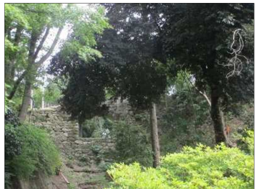
廊下橋の石垣への見通しが良くない
