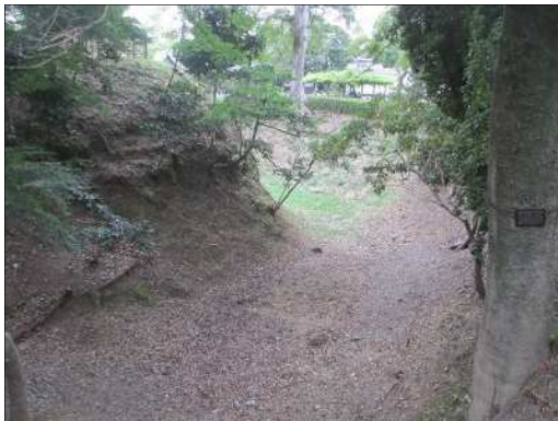
土塁が崩れている
