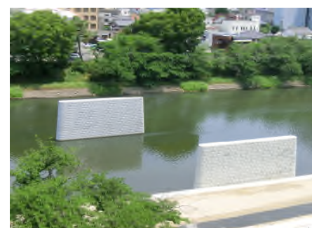
(仮称)乙川人道橋橋りょう下部工事
