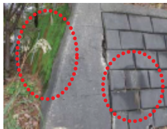
水がしみだしている擁壁 湧水部分にコケが生えている擁壁 (提供：社団法人 全国宅地擁壁技術協会)
