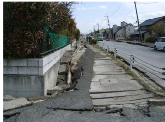
写真 1-2 地下埋設物の浮き上がり
