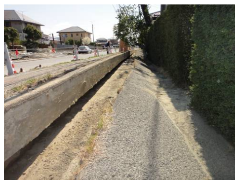
写真-6 道路側溝の隆起現象 6)
