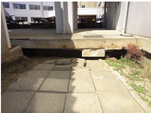
写真3-4 建物の基礎地盤の沈下 6)
