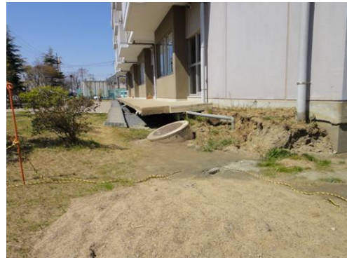
写真3-4 建物の基礎地盤の沈下 6)
