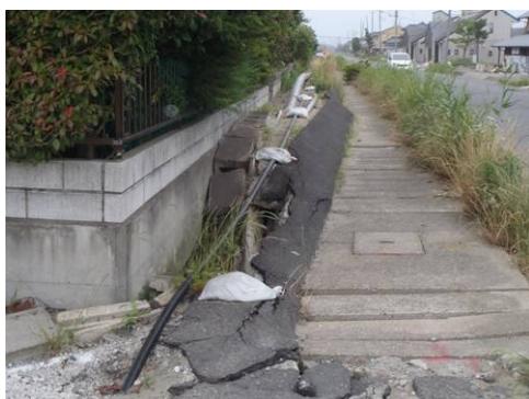
写真-7 ライフラインの浮き上がり現象 6)
