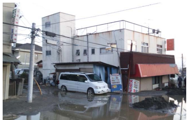
写真 1-3 建物の傾斜被害
