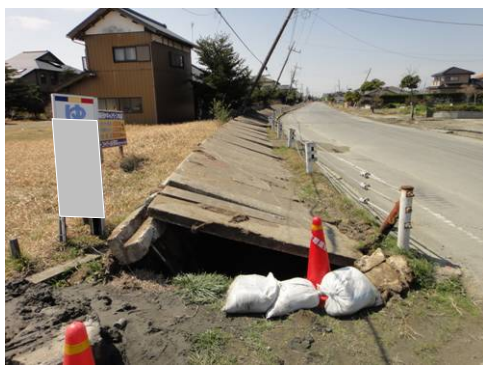
写真-6 道路側溝の隆起現象 6)
