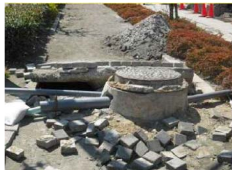
写真 1-5 マンホールの浮き上がり現象
