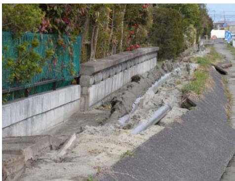
写真-7 ライフラインの浮き上がり現象 6)
