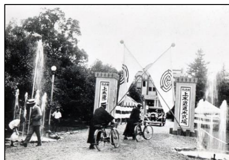
水道の通水式 (現在の岡崎公園)
