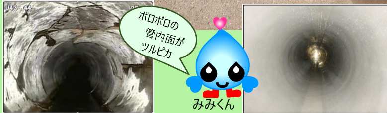
▲老朽化で内面がポロポロの下水道管 → 管更生(内面再生工法)
