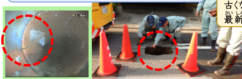
▲老朽化(ひび割れ、隙間)した下水道管による道路陥没事故
